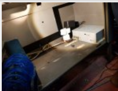
Mise en place du boîtier
