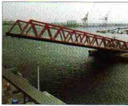
Le pont basculant de 1 550 t est actionné par deux centrales hydrauliques.
