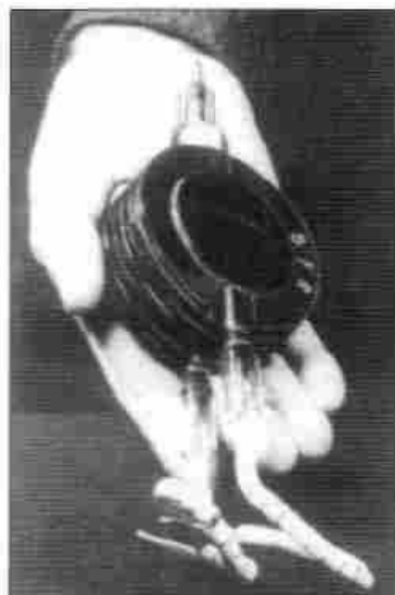
Magnétron à cavités 1 MW Bande S (1950)
