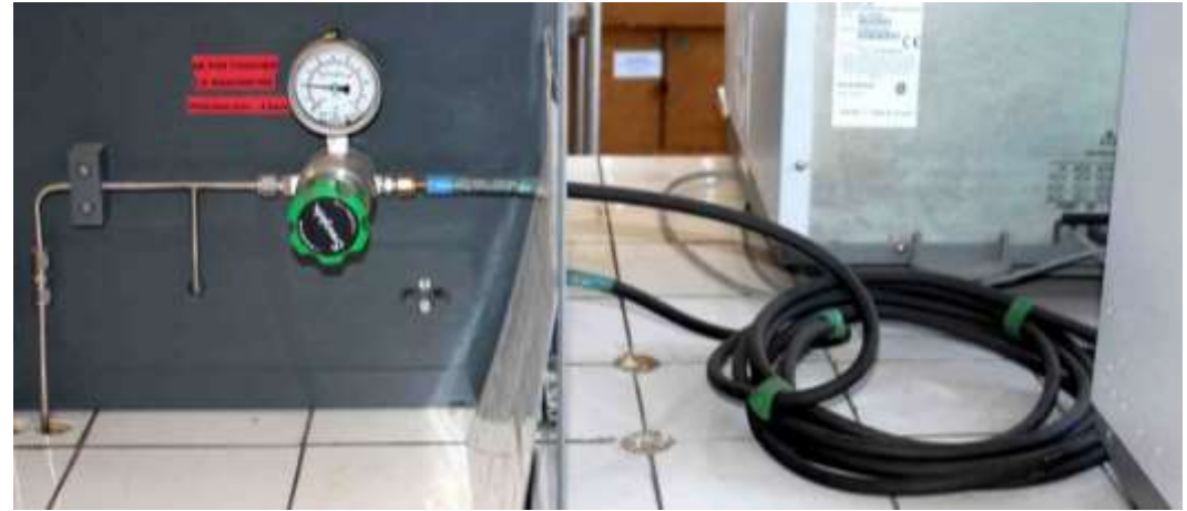
Figure n° 9 : manomètre réglant l'arrivée d'air comprimé
