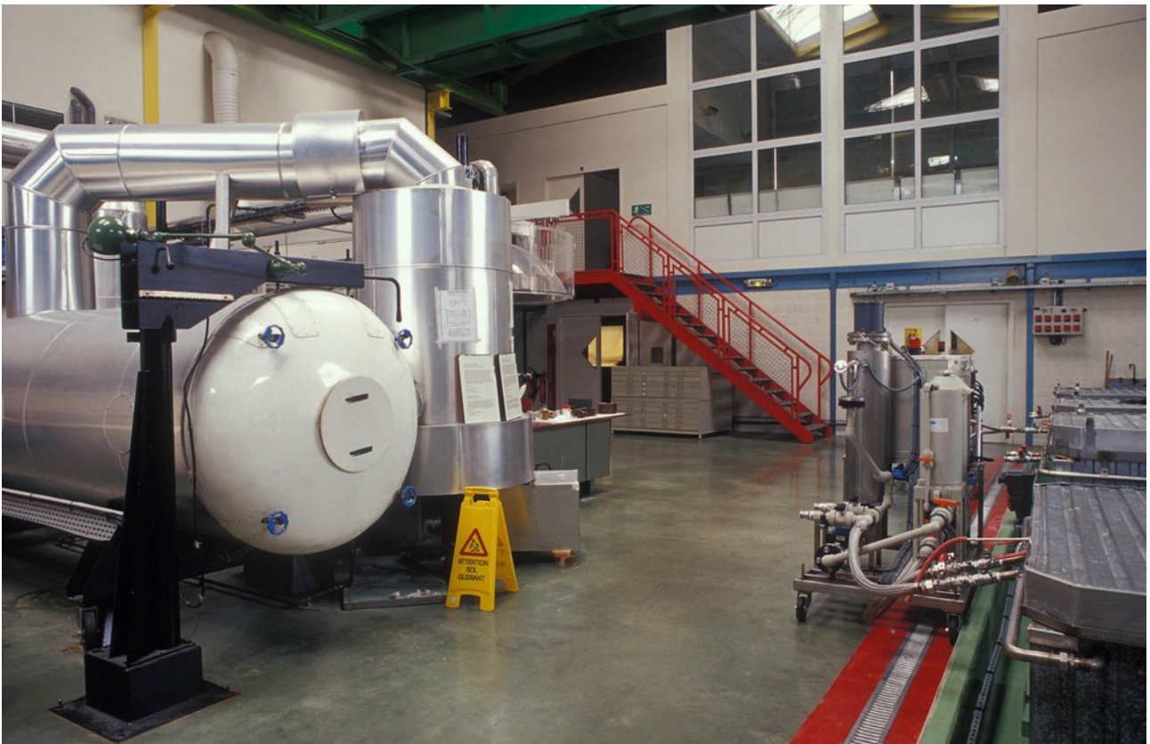
2005 : détail de la vue précédente avec, sur la droite, l'un des deux groupes mobiles de chauffage et filtration des bains de PEG aux diatomées.
