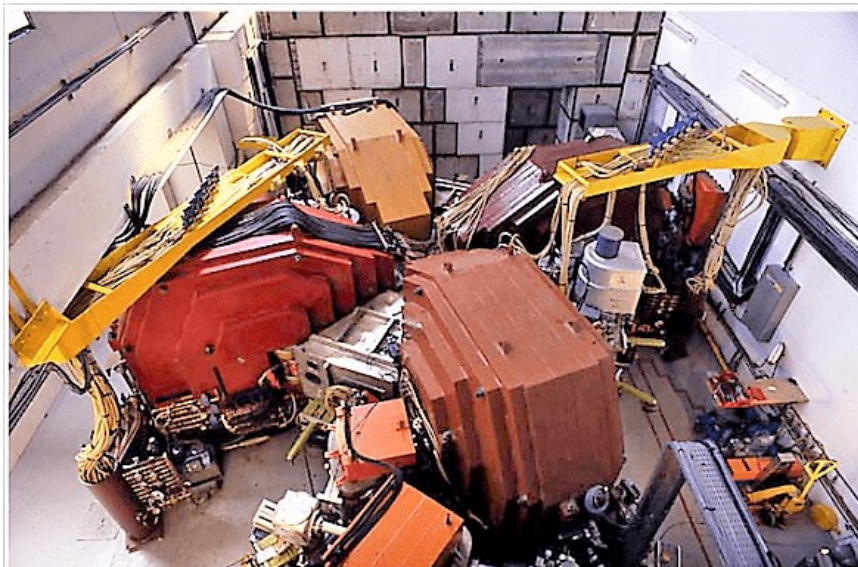
Construction PA : Montage final (vue d'ensemble) Mai 1962
