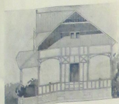
EXTERIEUR DU PAVILLON
