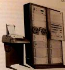
Photo 7.3 MAT 01 en baies à trois, avec lecture de bandes perforées et télex
