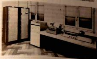
Photo 8.1 L'installation de commande. De gauche à droite : l'interface, le MAT 01, le pupitre.
