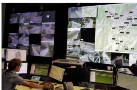
On est ici au PC Centre-Est de la DIR Centre-Est qui, avec les PC "feux tricolores" et d'information multimodale de la Métropole, forme le PC Métromobilité. Un bel exemple de mutualisation réussie et performante. Photo Le SUD/N.P.
