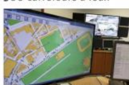
Parmi les écrans du PC "feux tricolores", celui-ci permet de voir le couleur des feux en temps réel (ici, boulevard Jean-Paul à Grenoble). Photo Le SUD/VP.
