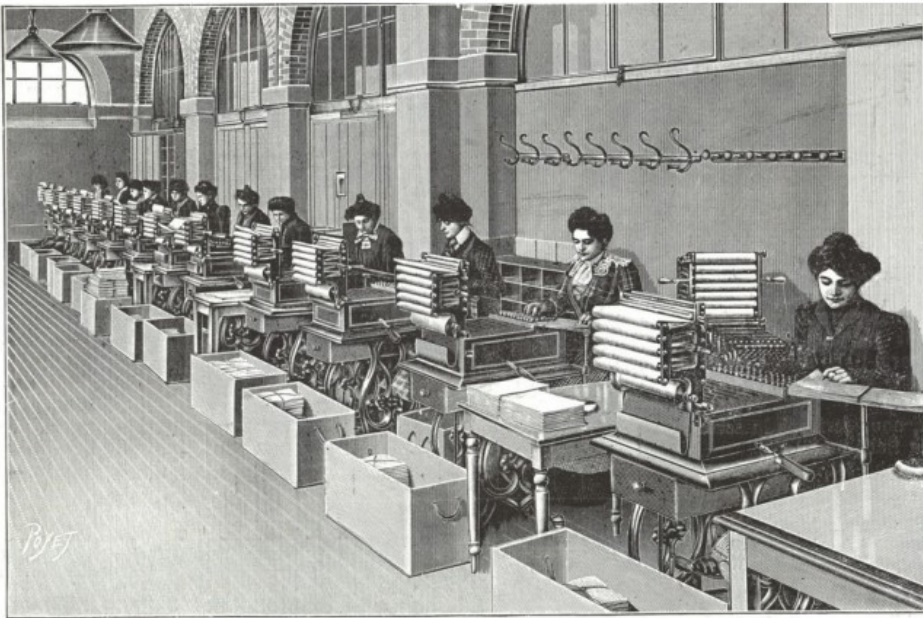
Une des salles de machines, où s'opère le dépouillement des documents.
