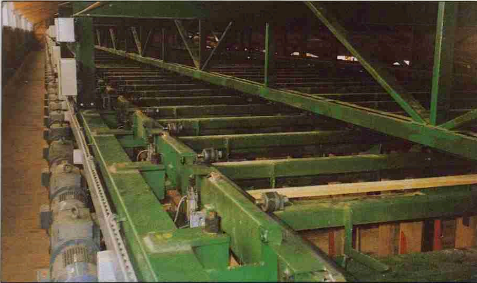
Les 55 cases sont gérées unitairement par un April 5000.
